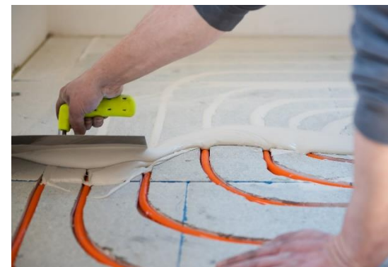
Afwerken d.m.v. dichtstrijken van de sleuven
