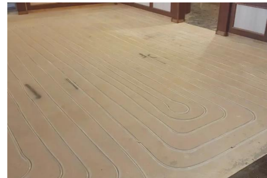
Monteren van vloerverwarmingsbuizen
